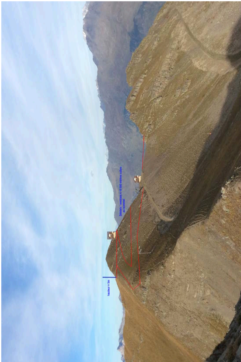
Travaux envisagés sur les crêtes, à la Pointe des Chaudannes, côté Karellis (déblais de 18 000 mètres cubes au sommet arasé et création d'une plateforme)
