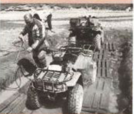
Zone improvisée de lavage des engins avec vidanges directe des eaux usées dans le torrent de la Valloirette.
