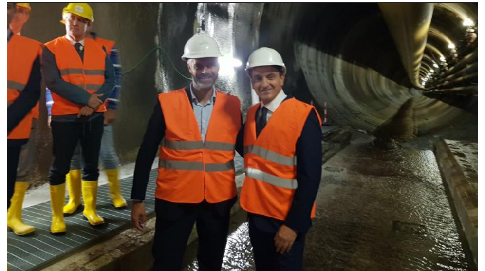
Laurent Wauquiez et Alberto Cirio ont visité la galerie de reconnaissance de la Maddalena, sur le chantier du Lyon-Turin. Photo Le DL/E.V.
